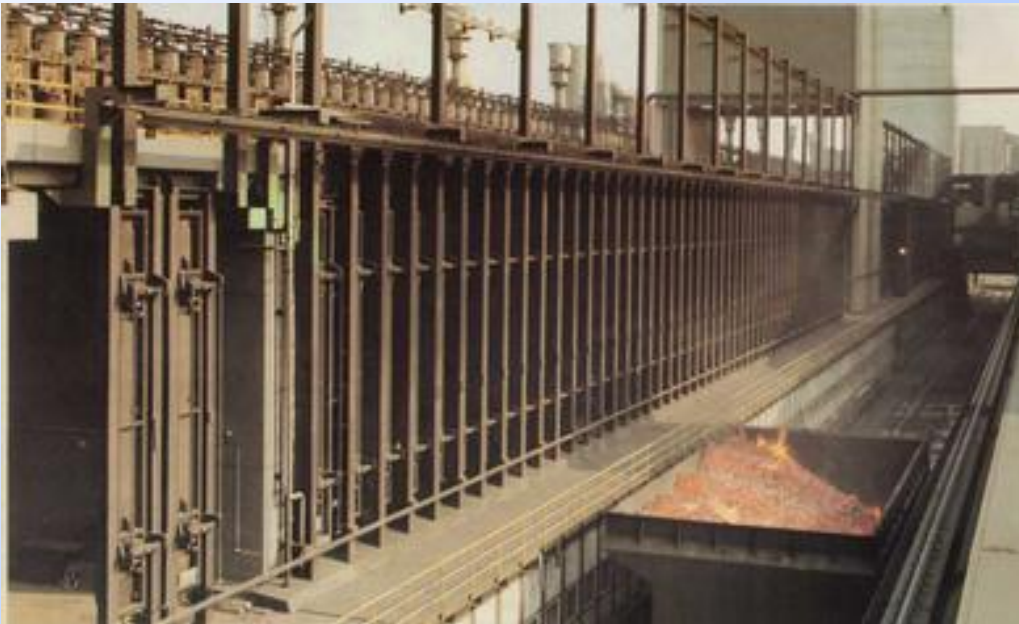
Típica Bateria de coqueificação
