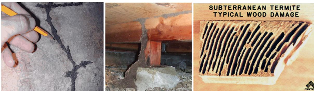
Figura 18: Sinais de ataque de cupins de solo em edificações e na madeira: Imagens da esquerda e central, com dutos construídos para interligar o solo à madeira; imagem da direita, apresentando o dano típico causado por cupins de solo.
