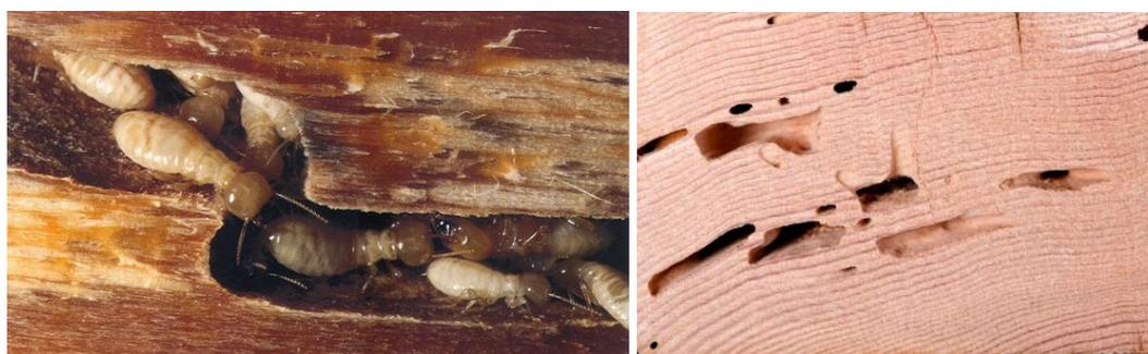
Figura 20: Sinais de ataque de cupins de madeira seca: Imagem da esquerda, galeria com presença de cupins; imagem da direita, apresentando o dano típico causado por cupins de madeira seca.
